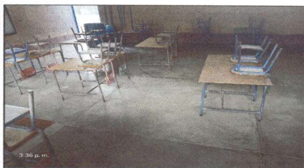
FOTO 3: Sustitución de piso cerámico
