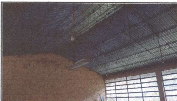
FOTO 9: Instalación de unidades luz (incluye interruptor, ducto y cable eléctrico)
