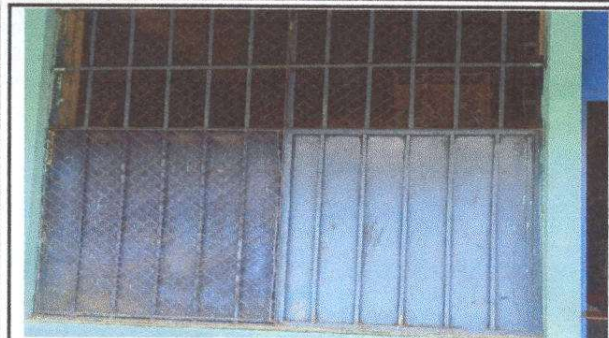
FOTO 1: Mantenimiento a balcones de metal
