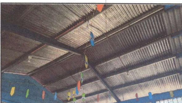
FOTO 10: Instalación de unidades luz (incluye interruptor, ducto y cable eléctrico)
