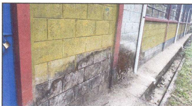
FOTO 5: Pintura en muros exteriores e interiores
