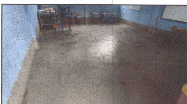
FOTO 4: Sustitución de piso cerámico
