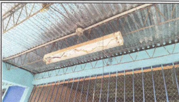
FOTO 8: Sustrucción de focos ahorradores
