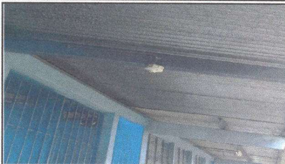
FOTO 7: Sustrucción de focos ahorradores
