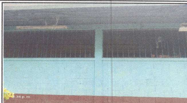
FOTO 2: Mantenimiento a balcones de metal
